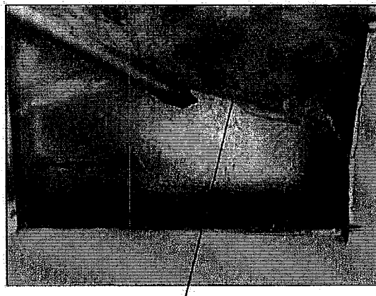
Ve vnitřní skladbě je výplň z minerální izolace
